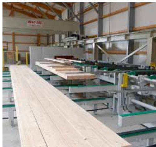
Pakete mit größeren Stückzahlen gleicher Dimension stapelt die H.I.T.-Installation von selbst
