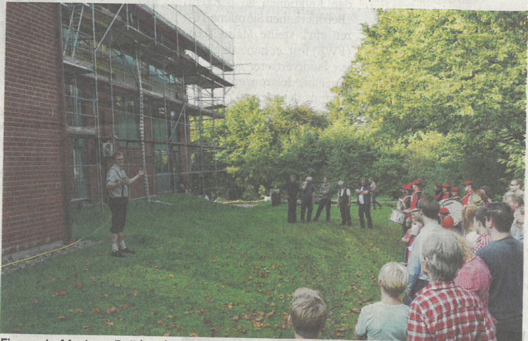
Firmenchef Andreas Boll (links) sprach gestern beim Richtfest für einen Anbau zu Mitarbeitern, Handwerkern und Musikern.
