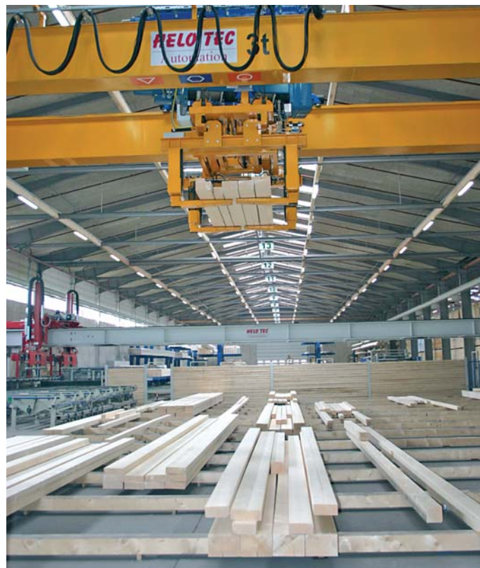
Sonderanlagen von Helo Tec sorgen für die Manipulation der fertigen KVH-Stangen
