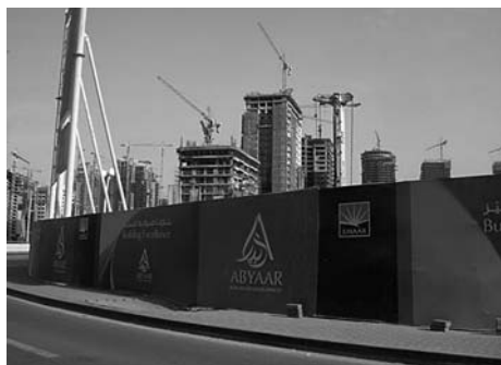
Gigantischer Bauboom in Dubai/AE
