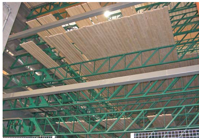
Die keilgezinkten Lamellen werden auf der Springer-Etagensortierung zwischengelagert
